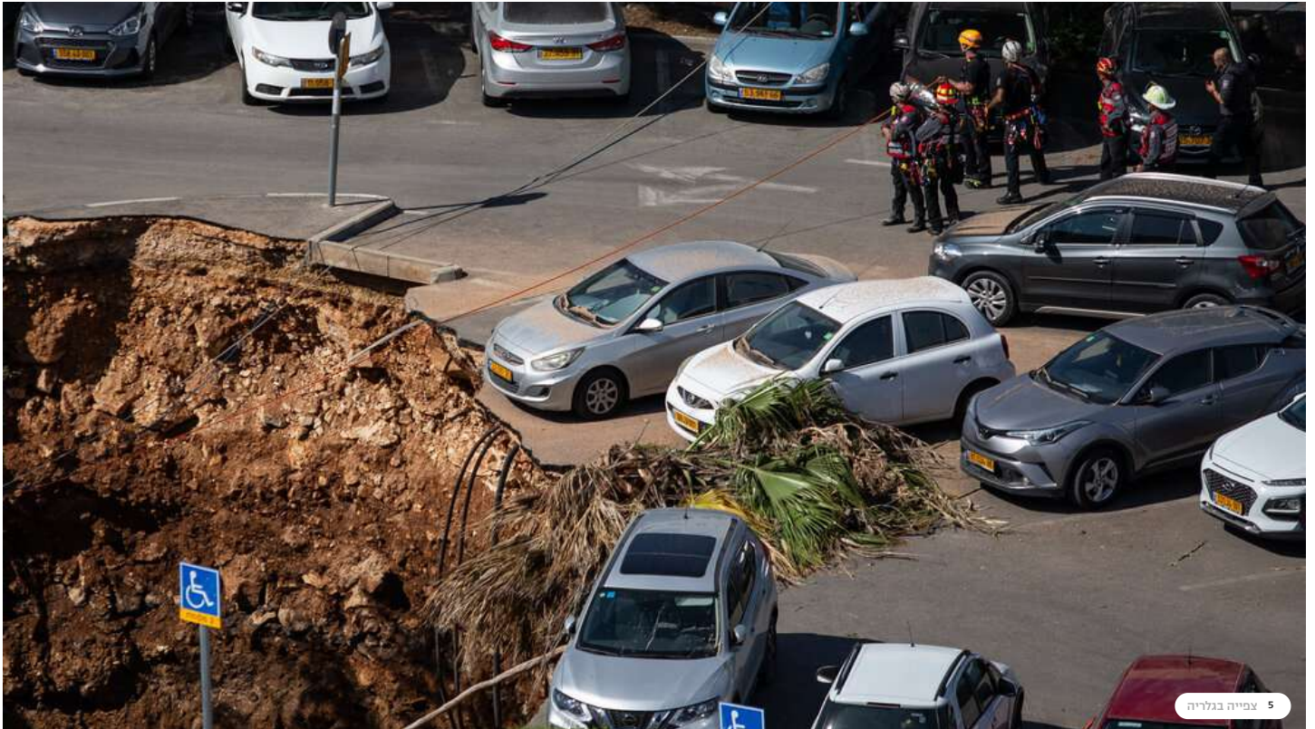
5 צפייה בגלריה "לא היו פיצוצים בשטח החפירה". קריסת החניון בשערי צדק (צילום: אלכס קולומויסקי)
